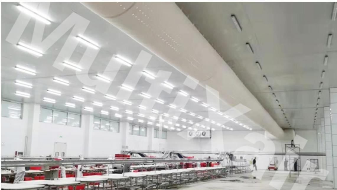
下面我们就来了解下是如何杜绝凝露的问题：1. 布袋风管开孔灵活，它可以朝防结露表面送风，通过一定风速促进表面蒸发，阻止凝结水。2. 在近吊顶高度形成一个温度较低区域，阻止水蒸气上浮。3. 潮湿空气经过机组，由布袋风管向防结露结构表面射流的空气湿度已经降低，所以近表面区域的空气水份含量低，不容易在结构表面凝结。有着防凝露的势，加上其在游泳馆使用美观性，不得不说“游泳馆防凝露，布袋风管”。纤维织物风管系统的形状选型时根据客户需求以及实际应用的要求来选择的。风管，就选米希（上海）环境技术有限公司，用户的信赖之选，有想法可以来我司咨询！雅安软风管制作
