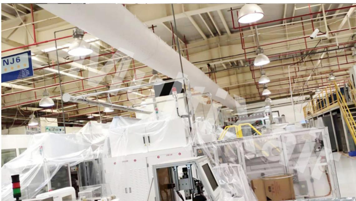
机房空调组采用传统的“先冷环境、再冷设备”的工作方式，不能适应大功率机房的需求，难以避免机房过热区的存在，且浪费电能。纤维织物风管在机房空调通风系统的应用实现机房定点
